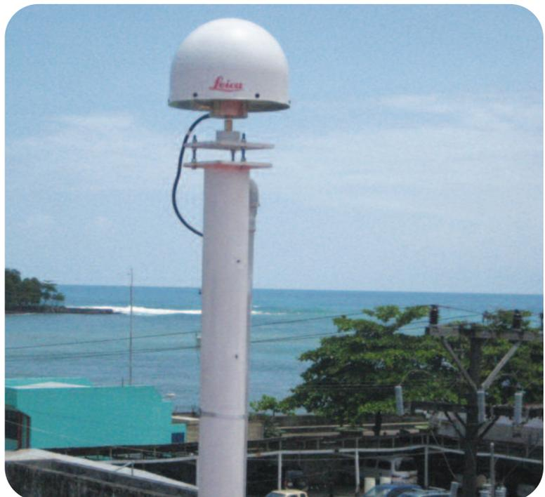
Figura 2. Antena de recepción de la estación GNSS en Limón.
